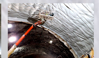
安裝防水膜進行中
