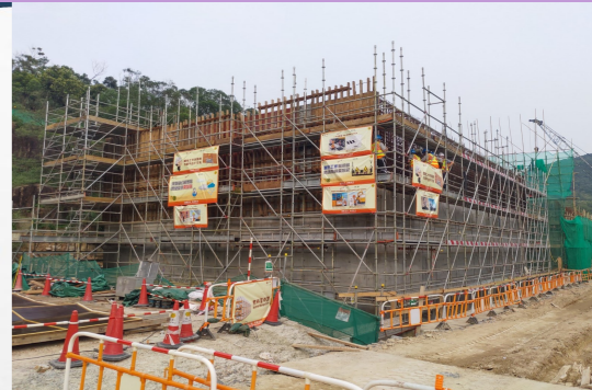
興建中的配水庫
