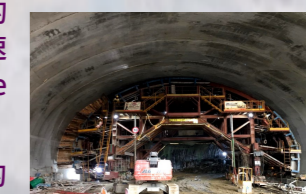
隧道襯砌建造工程
